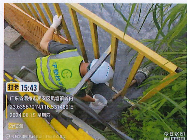
施工 1 标 2#支洞隧道洞口排水
