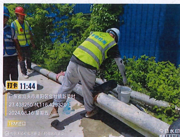
施工 5 标 TBM 隧道开端洞口排水
