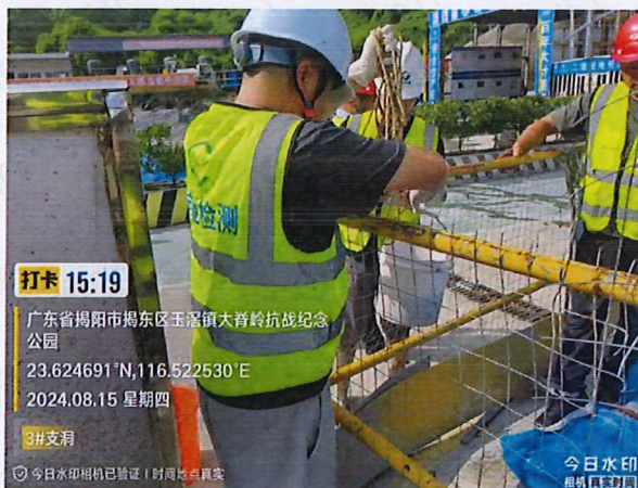
施工 1 标 3#支洞隧道洞口排水
