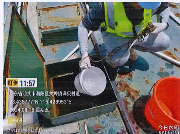
施工 5 标 TBM 隧道开端生活污水
