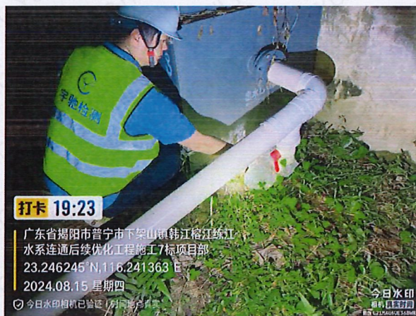
施工 7 标项目部厨房生活污水
