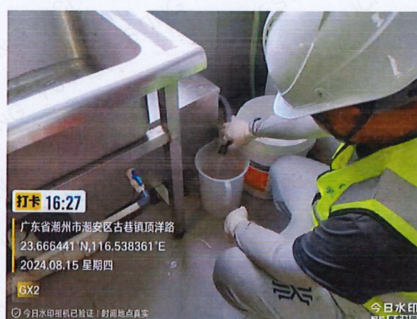
施工 1 标 GX2 厨房生活污水
